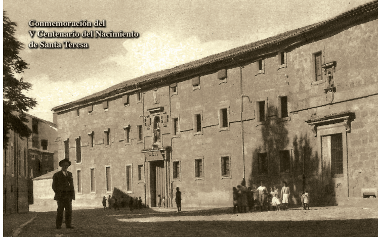
Edificio del colegio de Teresianas. Foto Pizarro.
